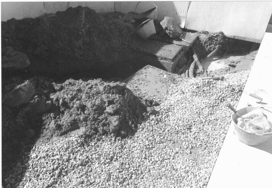
Escavação para completar mais ou menos 6 metros de cano pvc que faltaram do apartamento 25 até a fossa. Fotografado em 18/02/2013.
