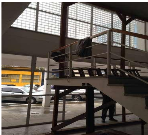
Foto 2: Prédio Novo Interditado
