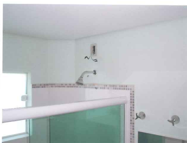
FOTO 34 Tomadas – (Falta), fiação acessível – vários apartamentos;
