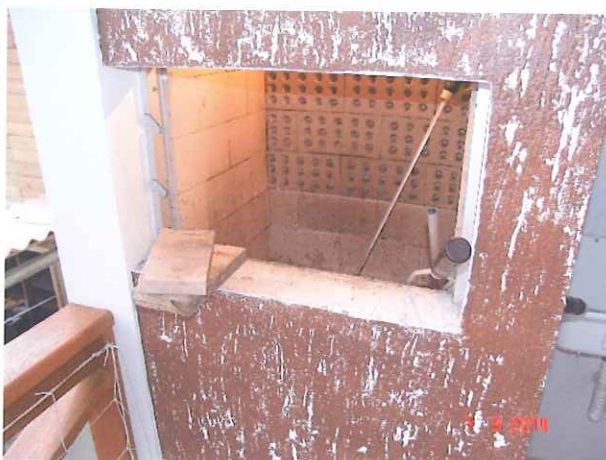
FOTO 29 Revestimento refratário da churrasqueira solto, no apto. 28;
