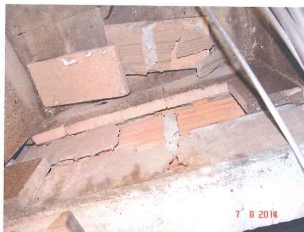
FOTO Revestimento refratário da churrasqueira solto, no apto. 28;
