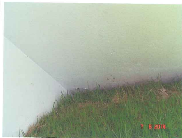
FOTO 26 Reparo executado no revestimento da base da escada externa;
