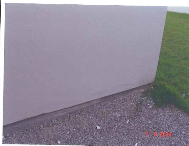
FOTO 24 Reparo executado no revestimento da base da fachada, no apto. 25;
