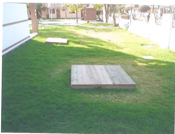
FOTO 38 Tampas feitas com madeira, baixa resistência em contato com o solo;
