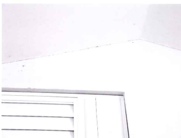
FOTO 06 Descolamento entre a parede e a laje;
