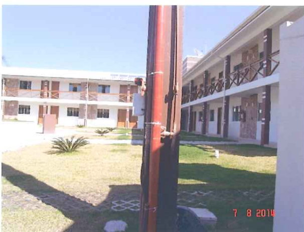
FOTO 05 Intervenção feita no ramal de alimentação;
