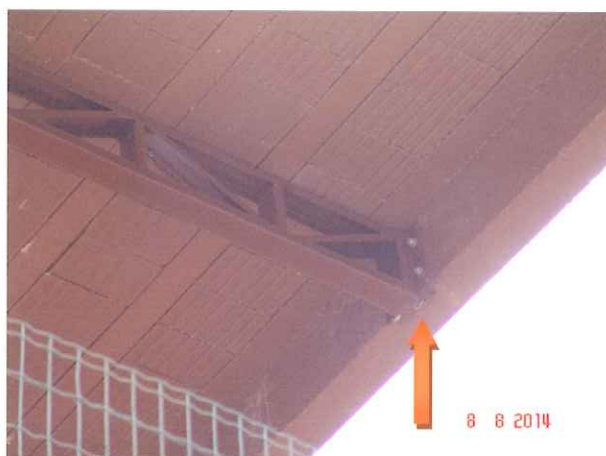
FOTO 04 Reforço metálico após flexão da laje e vigas de concreto;
