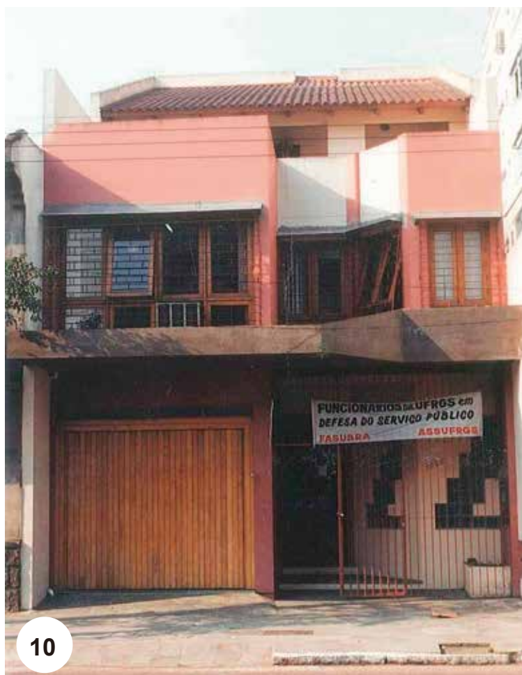
Na metade dos anos 90 a ASSUFRGS adquiriu a sua sede própria. Na foto ao lado, podemos ver a fachada original do sobrado localizado na Avenida João Pessoa, 1392. Ao longo dos anos a sede centro passou por reformas para ampliação do espaço interno e melhor atendimento dos filiados. (Arquivo CEDEM ASSUFRGS)
